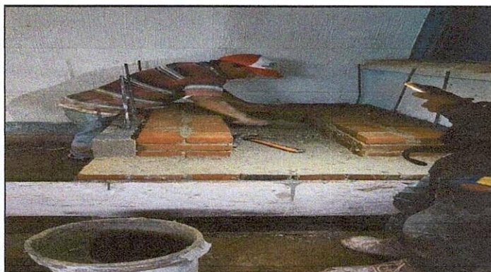
Foto 3: Construcción de estufa rural.
