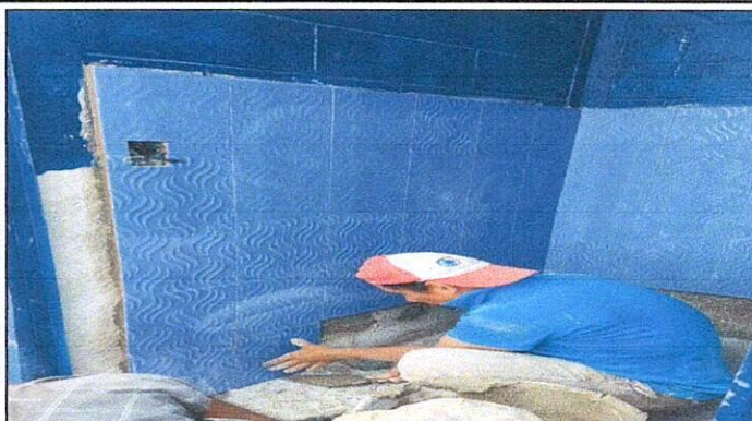
Foto 2: Colocación de azulejo en baños.
