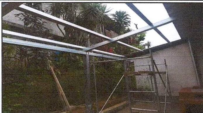
Foto1: Reparación de cocina.
